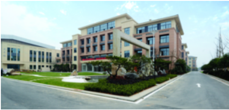
樾园校区教学楼
